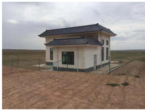
一级泵站管理房
