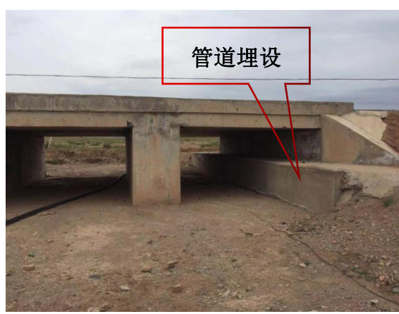
管道穿越公路
